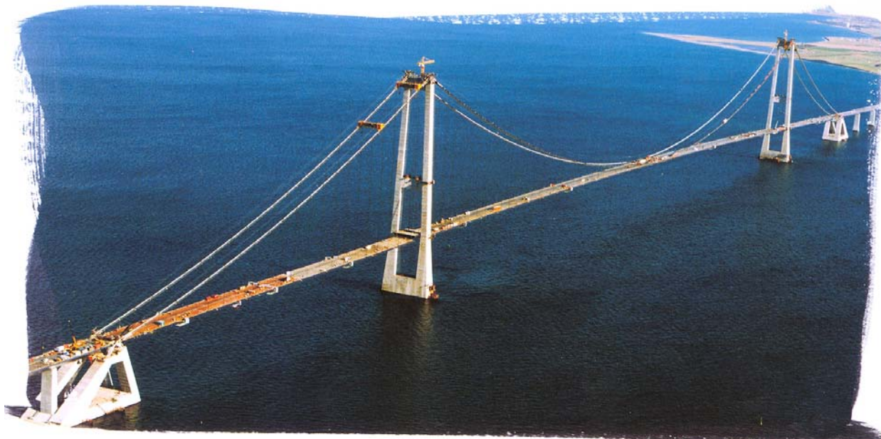
Obr.1.31. 6,8 km dlouhý ocelový most spojující dánský ostrov Zealand s pevninou. Dva hlavní kabely mají průměr 826 mm. Jsou vyrobeny z taženého drátu.
