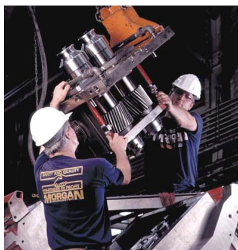
Obr. 5.34. Výměna celého uložení válců
