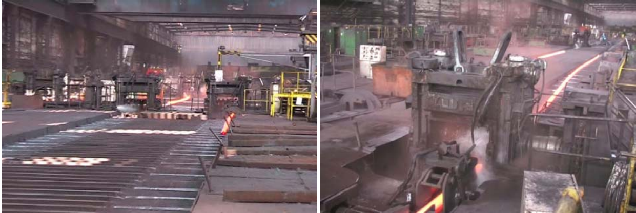
Obr. 6.41. Hotovní stolice č. 9, vlevo stolice č. 8 a příčný dopravník ke stolici č. 9, vpravo detail
