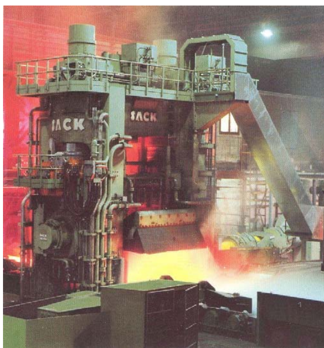
Obr. 5.36. 3,7 m kvarto (Thyssen Stahl, Duisburg)
