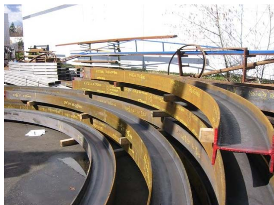
Obr. 5.27. Širokopřírubové nosníky připravené na stavbu mostní konstrukce
